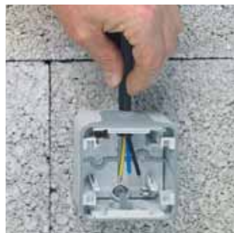
3/ A membrana do bucim assegura o IP 55 da instalação
