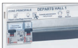
Exemplo de quadro equipado com etiquetas 0 387 20 em porta-etiquetas 0 203 99 e etiquetas 0 387 31/32
