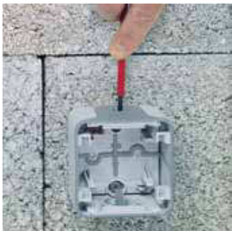
1/ Perfurar o bucim plano com auxílio de uma chave de fendas
