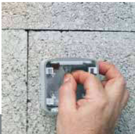
1/ Pré-corte do bucim puxando a guia de abertura
