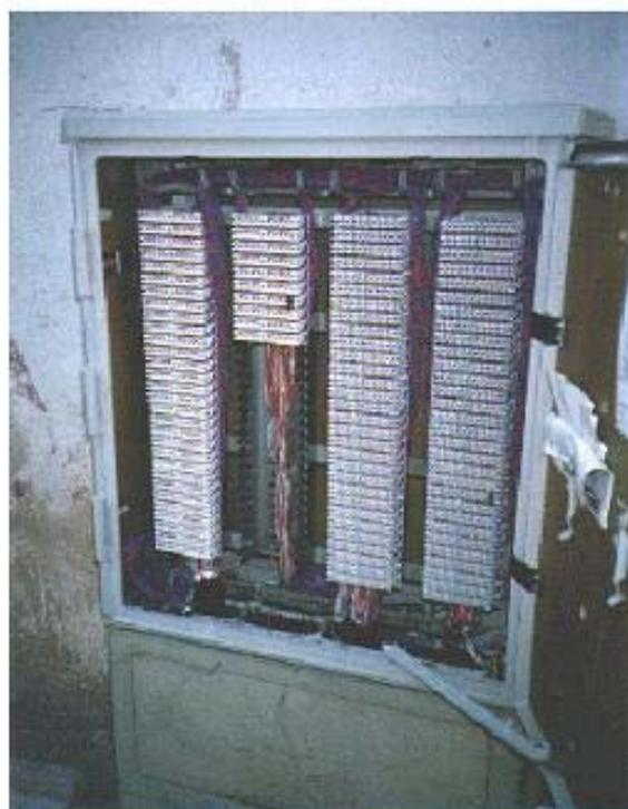
Figura 37- Exemplo de um RG-PC colocado em pedestal
