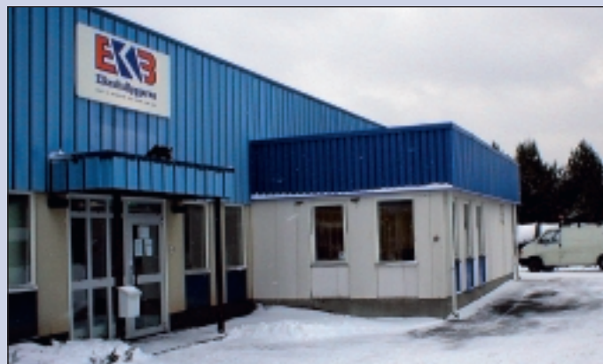
Elkraftsbyggarna fanns på plats mitt i stormområdet och ryckte ut direkt.
