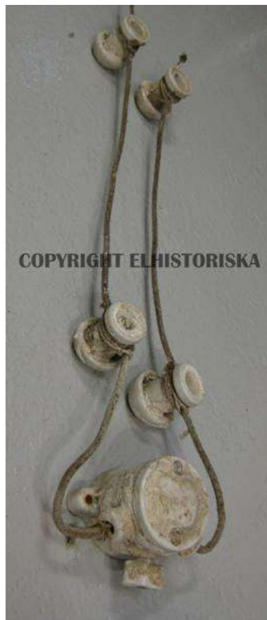
Vänster bild: knoppledning "HVG" (glansgarn) och VU i porslin, från tiden 1890-1920 för torra lokaler
