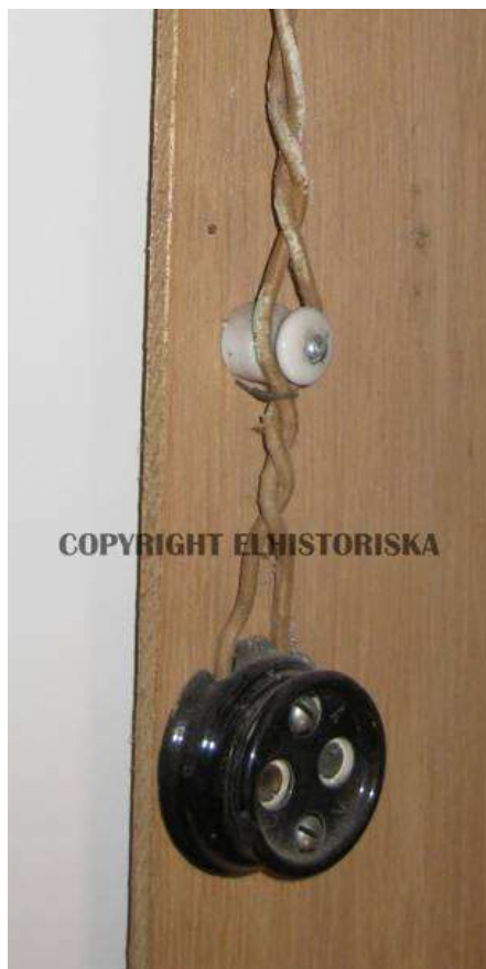
Vänster bild: knoppledning "HVG" (glansgarn) och VU i porslin, från tiden 1890-1920 för torra lokaler
