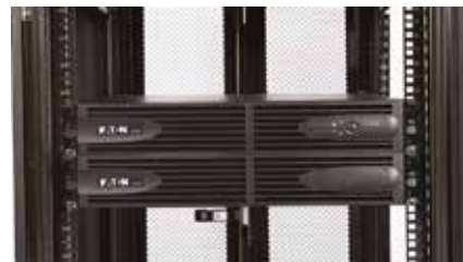
Eaton 5130 UPS, 2U rack alanı kaplar ve opsiyonel ek akü modülü de 2U yer kaplar.
