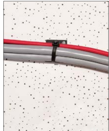
3. Eğer montaj tamamlandıysa, kablo bağı gerdirilerek elle veya bir uygulama el aletiyle kesilebilir.
