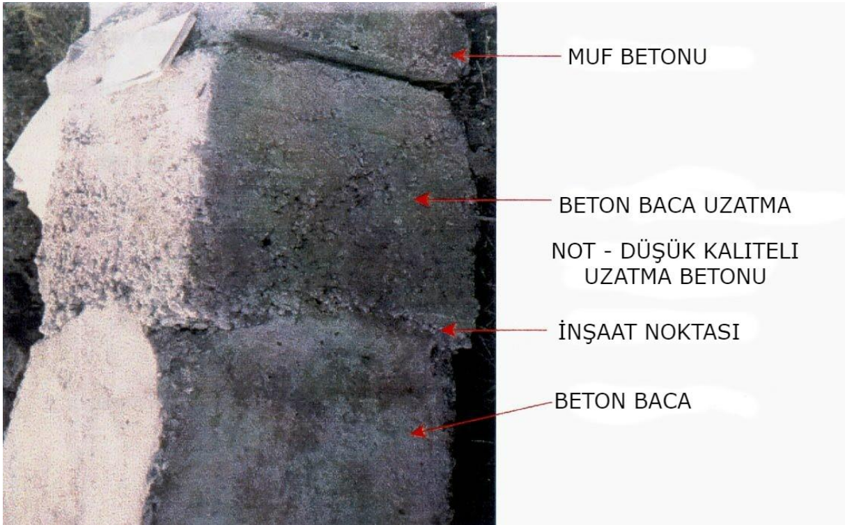
Şekil 11 – Bir beton bacadaki zayıf bir inşaat derzinin detayı
