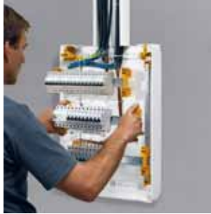
Alet gerektirmeden sökülebilen ray Kablolama kolaylığı sağlamak için raylar basit bir hareketle birbirinden bağımsız olarak sökülebilir
