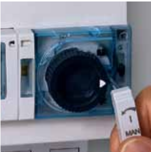
Kurma kolu periyodik test veya manuel kontrol için kullanılabilir
