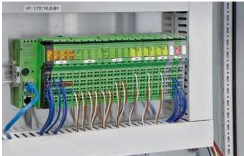
Şekil 3 :Inline kontrolör istenilen zamanda ölçüm değerlerini zaman etiketi ile sağlar
