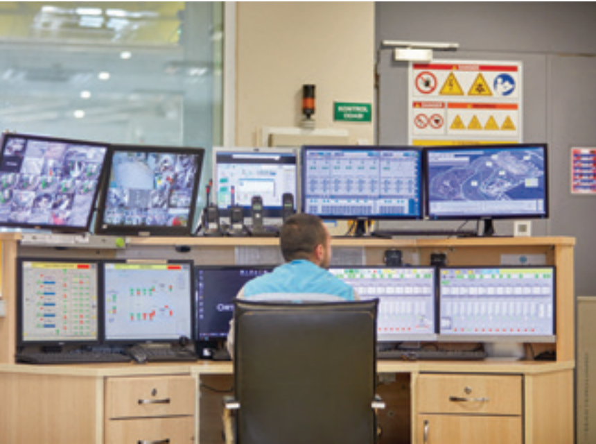
Resim 4: Su seviyeleri, gaz basıncı verileri kablosuz iletişim ile toplanmakta ve kontrol odasındaki dashboard üzerinden gösterilmekte.
