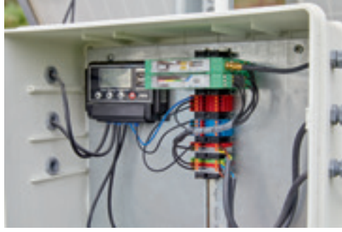
Resim 5: Kontrol kutularına yerleştirilmiş Radioline modülleri Bölge 2'ye taşınmaya hazır
