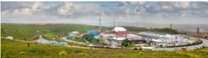
Resim 1: İstanbul Odayeri çöp biriktirme alanında metan gazından 33 MegaWattsaat (MWS) elektrik enerjisi üretilmekte
