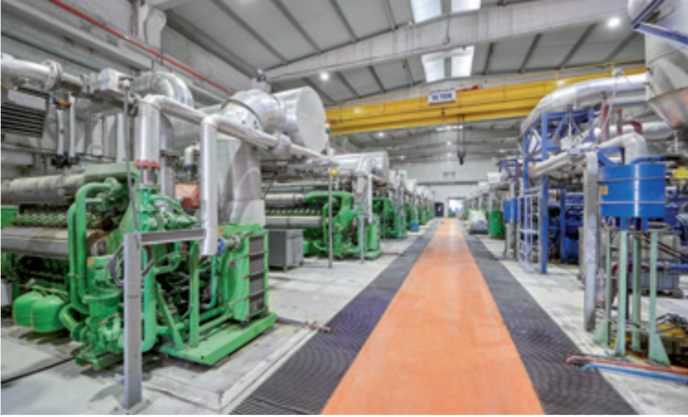
Resim 2b: 32 gaz türbini çalıştırılarak toplam 33 MWs enerji üretilmekte.
