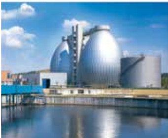
Su / Atık su istasyonu
