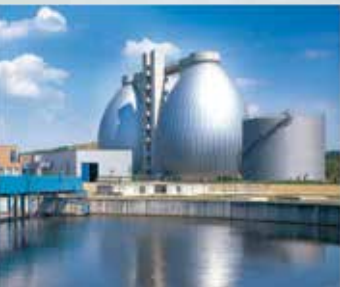
Su / Atık su istasyonu
