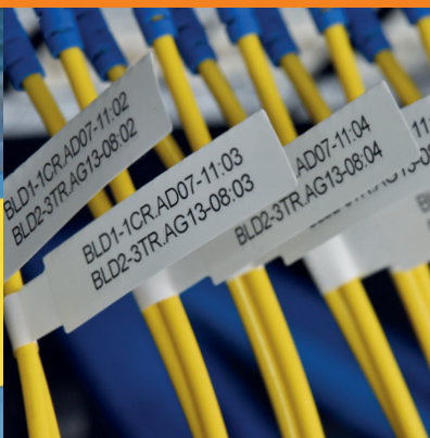
Cable ID - Fibre
